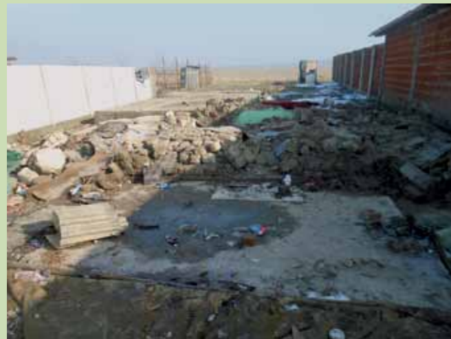
Hier wird das Fundament gelegt.
