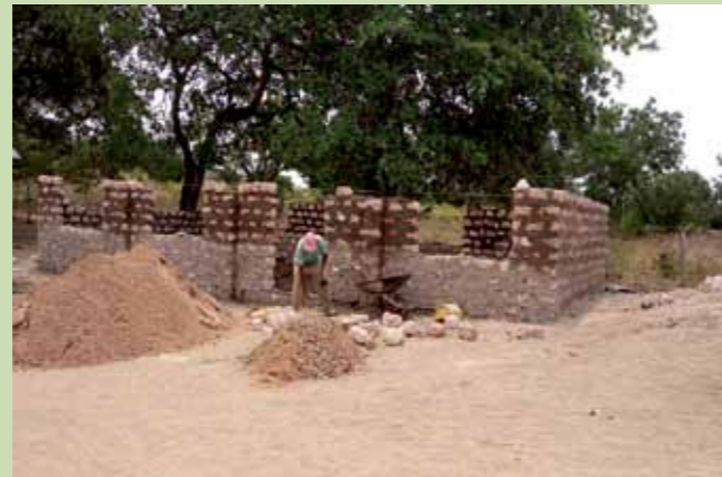
Der Mehrzweckraum im Bau.
