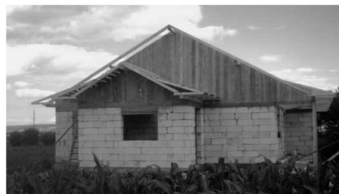
Das neue Haus im Rohbau; ein sicheres Zuhause für 2 Familien
