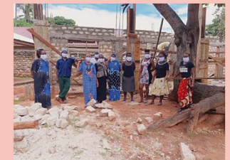
Baustelle der Schulraumerweiterung
